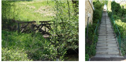
Passerelle et escalier
