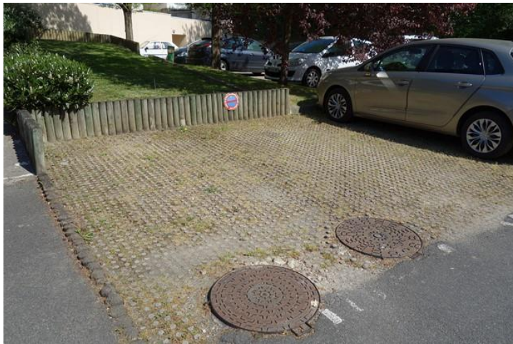
Figure 68 : Exemple de revêtement semi perméable (Home Sainte Lucie, rue Charles de Gaulle)
