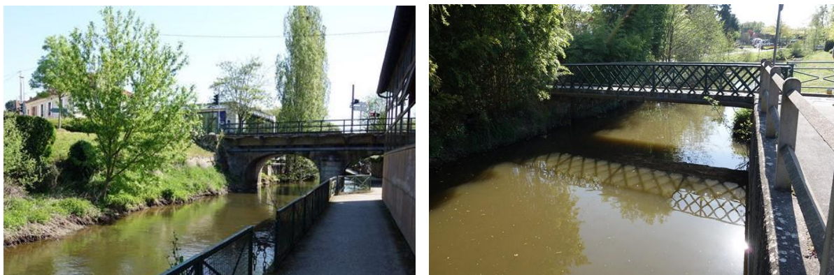
Figure 102 : Pont de la D446, passerelle rue Fénelon (en face de la rue Bossuet)
