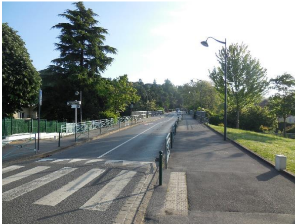
Chemin de Corbeville
