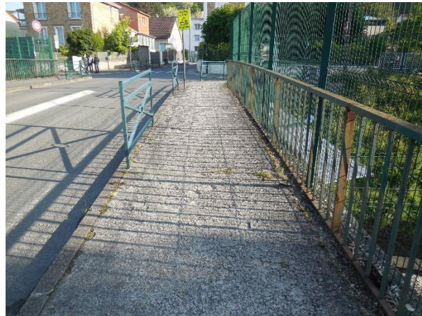
Chemin de Corbeville
