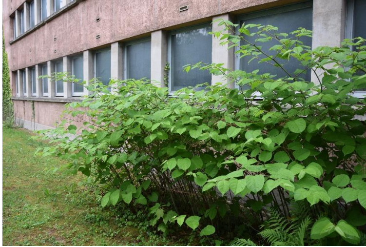
Figure 125 - Renouée du Japon sur site
