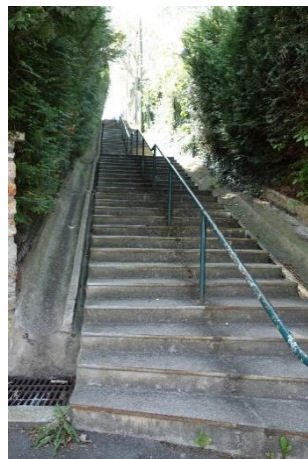
Escalier des Ulis
