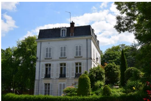
Maison des Associations, avenue du Maréchal Foch
