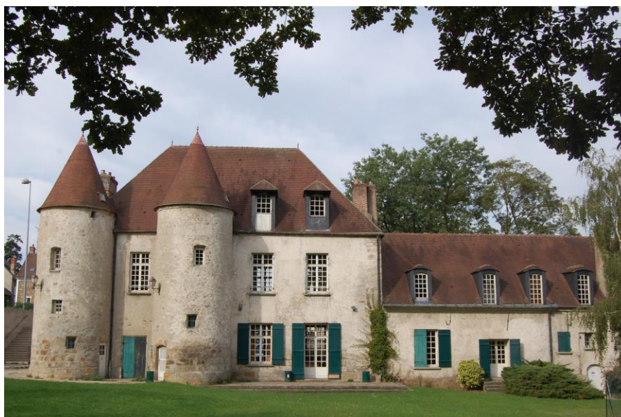
Ferme de la Bouvèche, allée de la Bouvèche
