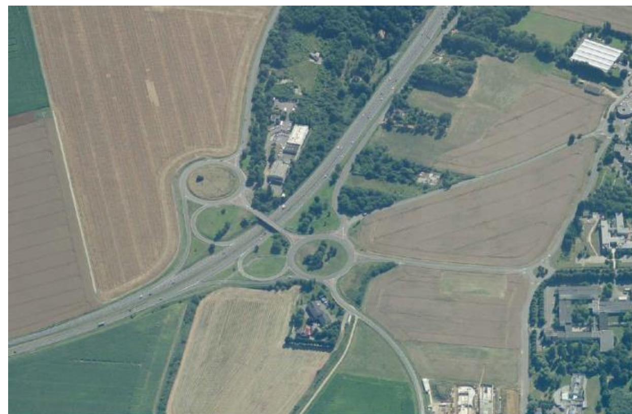
Figure 1. Vue aérienne de l'échangeur actuel.
