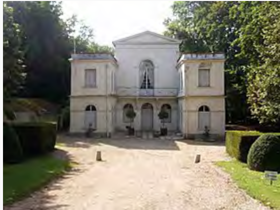
La façade orientale.
